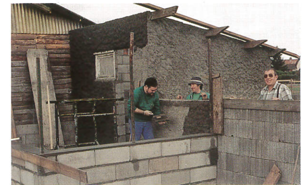
Les bénévoles mettent la main à la... truelle pour la construction de la nouvelle porcherie, encouragés par Rémy Camorali, président de l'Association et employé au Comité Central d'Entreprise des MDP.
