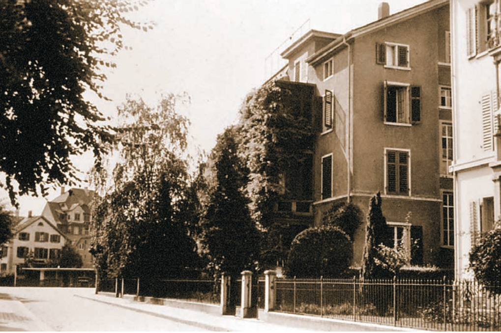
Der Gartenhof 1 und 7 in Zürich
