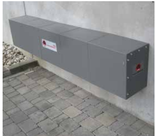
Wetterfeste Abdeckung zur Lagerung der Dammbalken
