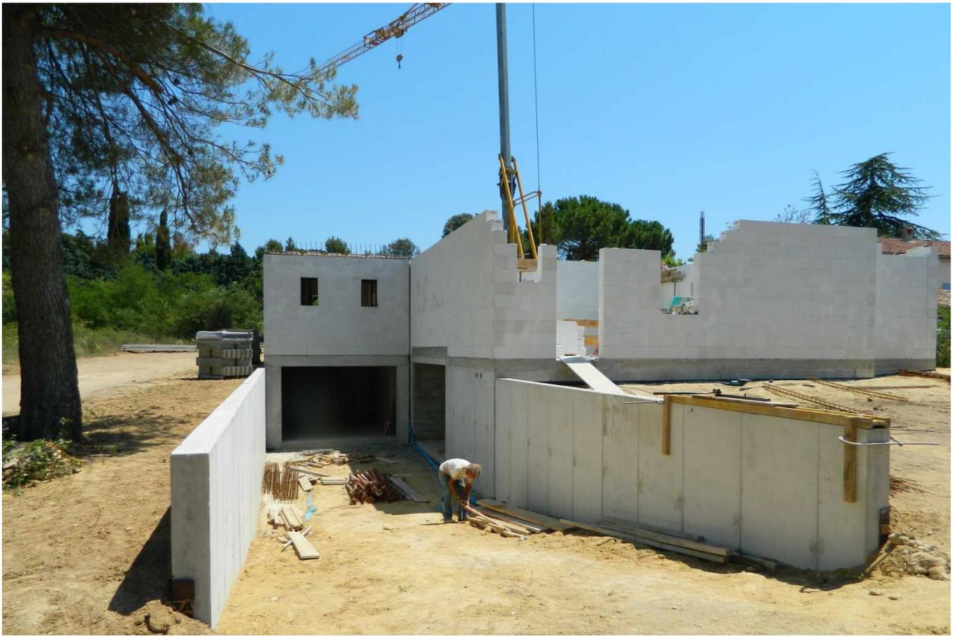
➤ **Onzième phase bis : l'élévation en béton cellulaire**
