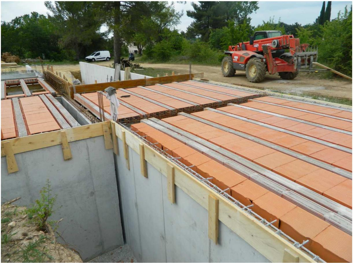
➤ **Neuvième phase bis : la réalisation du plancher en hourdis brique**
