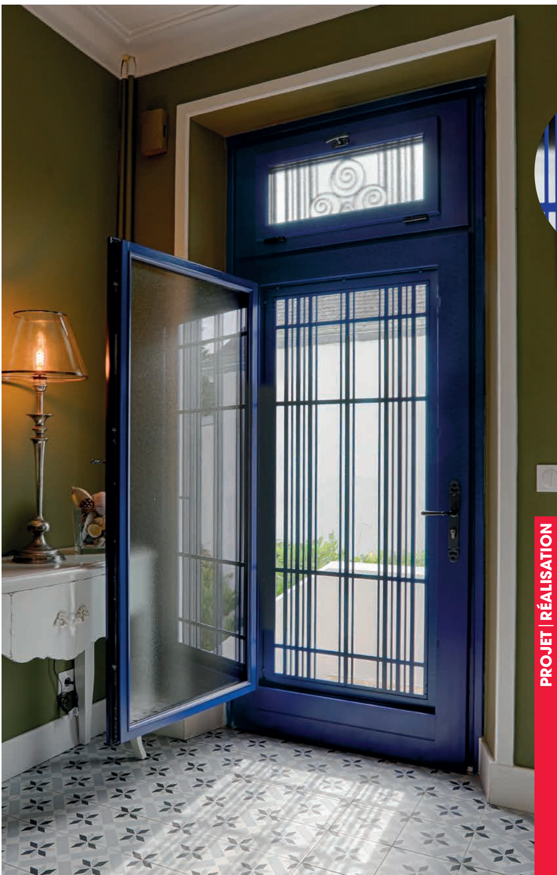
H 2480 : 1980 + 500 imposte / L 960. Bleu 5022 satiné. La porte intègre des grilles créées à partir d'un dessin du client, ainsi que des châssis ouvrants dans le vantail et dans l'imposte.
