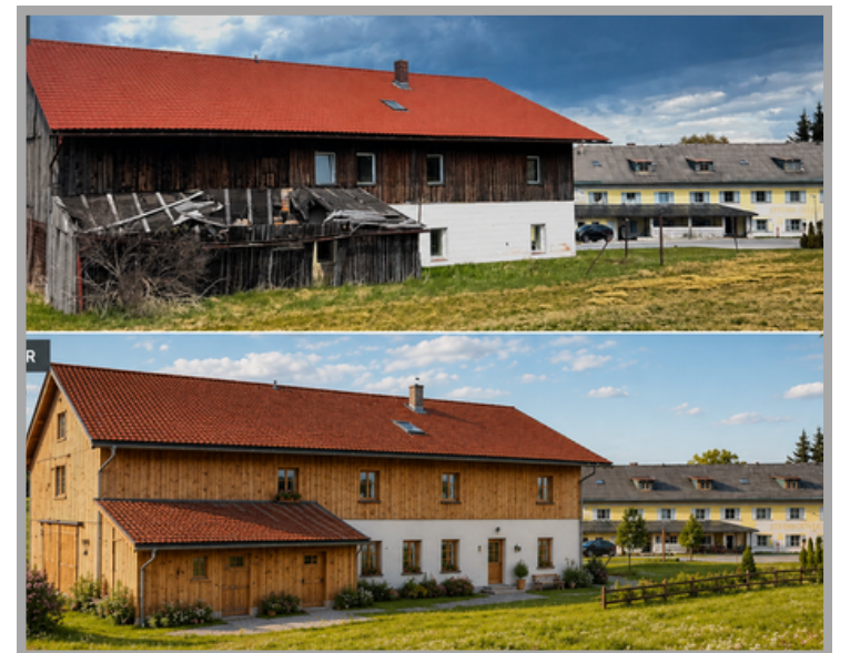
Ansicht von außen
