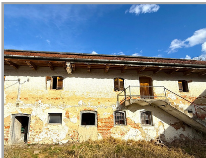
Ansicht auf Nebengebäude
