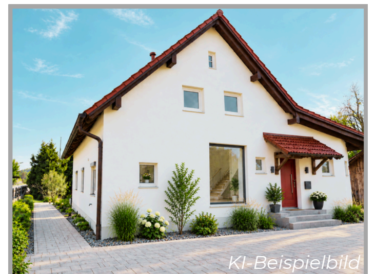
Ansicht auf Einfahrt und Hauseingang
