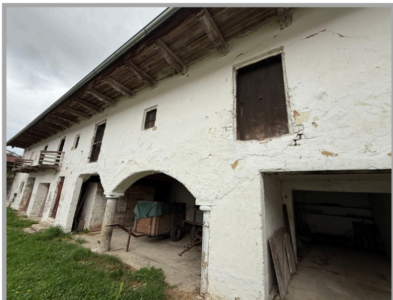
Blick auf das Nebengebäude
