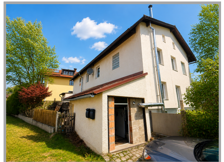
Ansicht von außen
