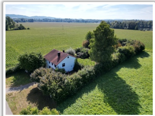
Bereich Haus mit Hecke
