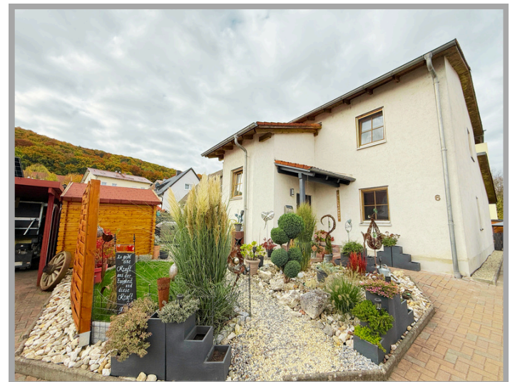
Ansicht von außen
