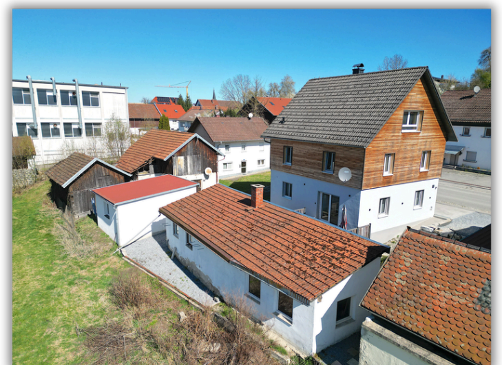
Ansicht aufs Haus von oben
