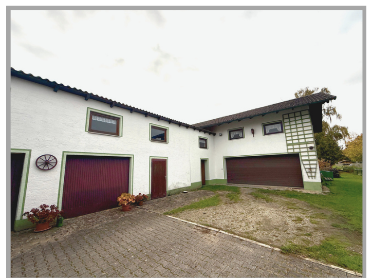
Ansicht auf Garage und Nebengebäude
