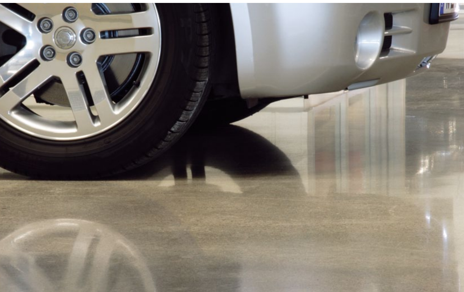
▼ Type de sol : Béton Lieu : Salle d'exposition voitures
