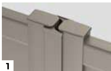
1 Battue centrale intérieure et extérieure avec embout de finition en aluminium. (Pour portail motorisé et tirant uniquement.)
