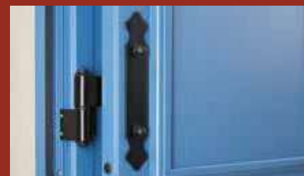
Détail montage gonds sur précadre
