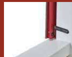
Guidage en tableau invisible de l'extérieur.
