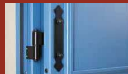
Détail montage gonds sur précadre
