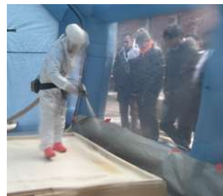
Démonstration de projection de mousse de polyuréthane
