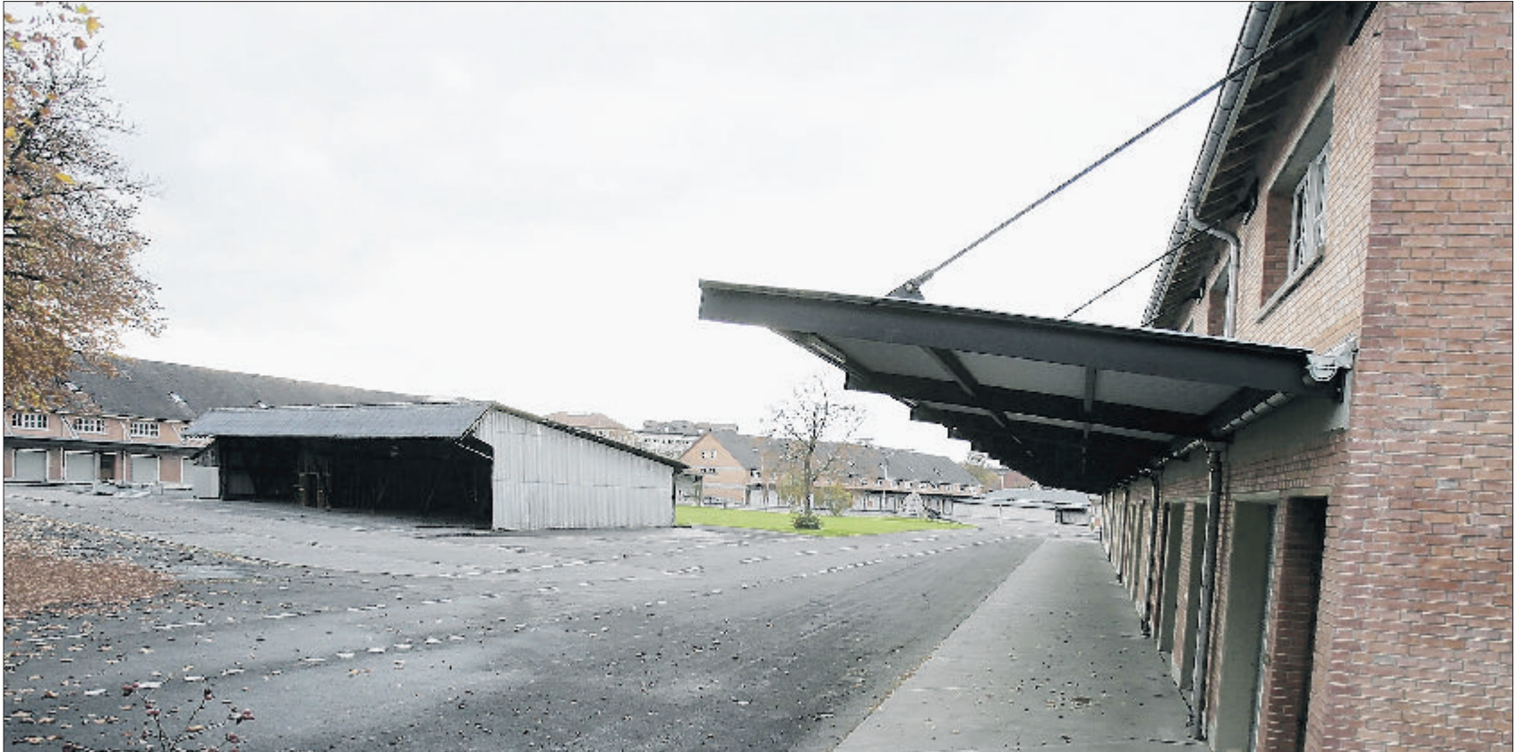
Das Zeughausareal in Uster soll dereinst ein attraktives Zentrum werden. Der Stadtrat will die Hälfte davon von der Armasuisse kaufen und legt dem Gemeinderat als ersten Akt ein Entwicklungskonzept in fünf Schritten zur Genehmigung vor. (Archiv)
