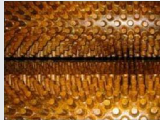
Tubos de convecção após a limpeza
