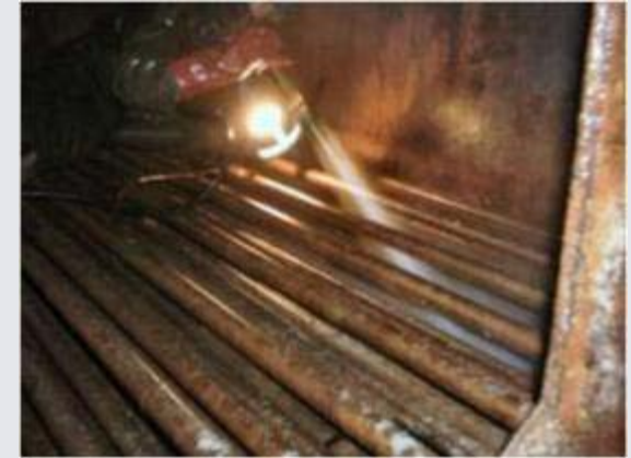
Limpeza de una caldera
