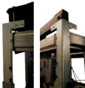
Teleskooppinen hissin kuilurakenteen yläosa
