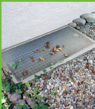
Recouvrement de sauts-de-loup
