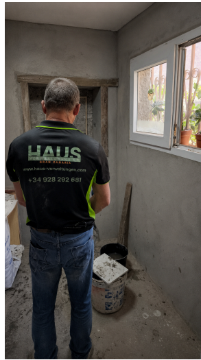
Vorbereitung und fachgerechte Bearbeitung von Innenwänden
