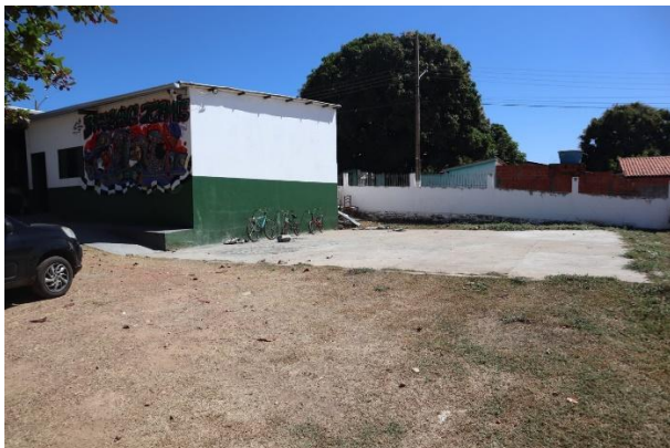
Bauplatz für Speiseraum
