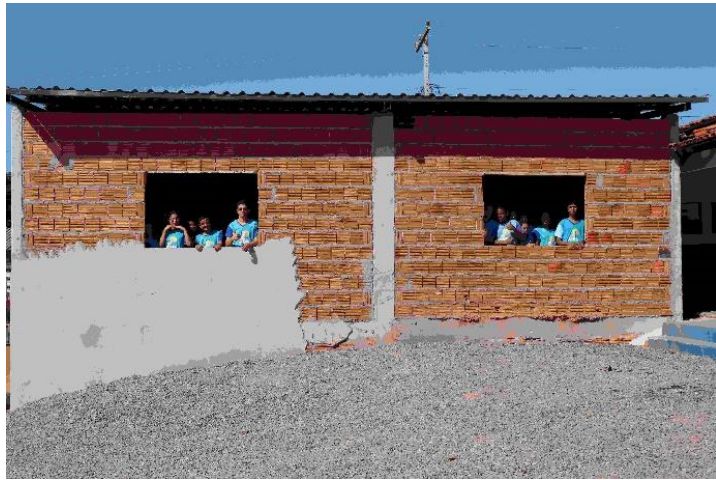
Gebäude noch im Bau
