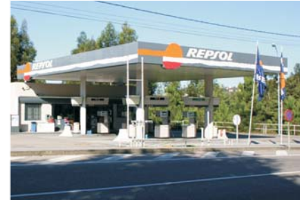
Vista de la gasolinera
