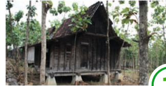
Abriss des Holzhauses
