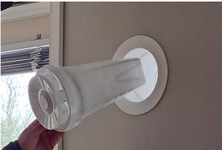
Kuva 2. Velco-korvausilmaventtiili ja suodatin.
