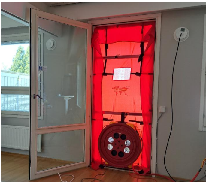
Kuva 7. Ilmatiiviuden mittaus paine-eromenetelmällä.
