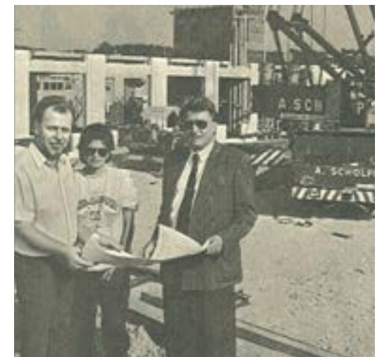
Mit Riesenschritten der Vollendung entgegen: Roland Rauschmayer, Tochter Andrea und Architekt Otto Zentner auf der Baustelle des „Multi-centrums“ auf der Wilferdinger Höhe.
