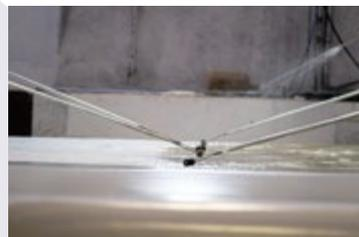
**03.** Application de la couche de barrière chimique à haute résistance pour éviter l'apparition d'osmose
