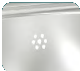
Rebosadero Overflow Déversoir
