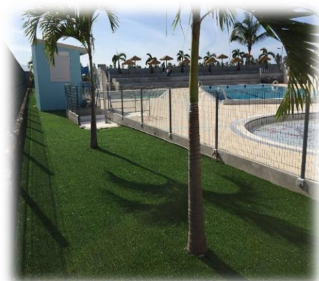
Pose de synthétique à la piscine de la Ville de L'Étang-Salé. Marque: Hatko. Modèle: Trinidad
