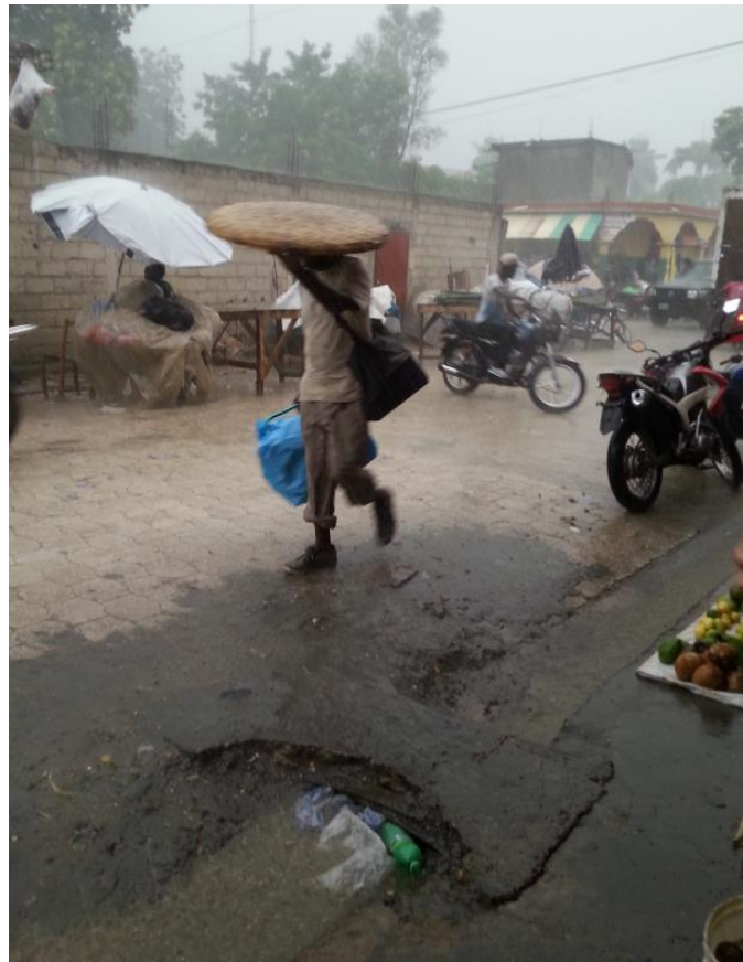
Pour vider rues et canalisations
