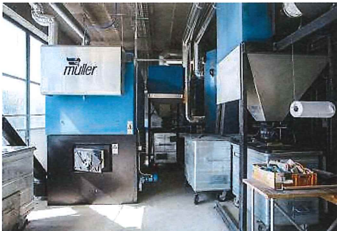
Anlagenwart Martin Trüssel ist Herr über die Holzsnitzel und die Holzsnitzelheizung, die den Nahwärmeverbund des Bürgerheims zuverlässig mit Wärme versorgt.
