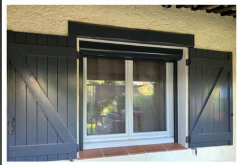
Volet roulant traditionnel pose dans coffre-tunnel
