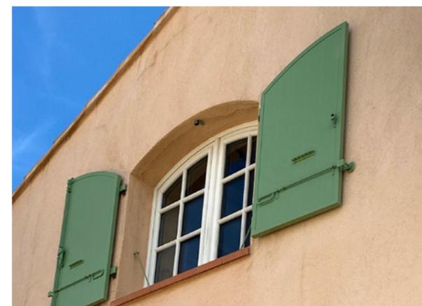
Volet battant isolant, modèle ISO avec dispositif de retenue à la française avec pièce murale
