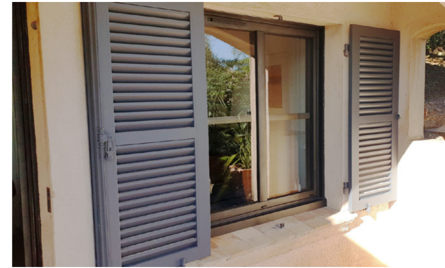
Volet battant persienné à lamelles fixes arrasées et extrudées de 56x11 mm, modèle Paris.
