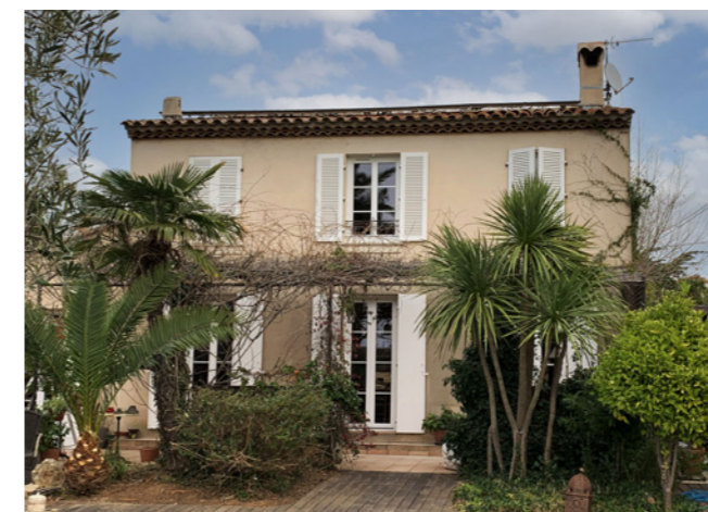
Etage : volets battants persiennés, lamelles extrudées, modèle JS Rez de chaussée : volets battants ISO RW, entièrement à panneau à lames horizontales
