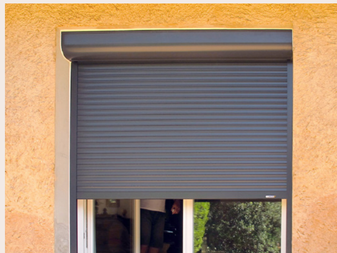
Pose tableau enroulement extérieur
