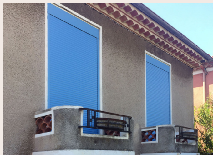
Pose tableau enroulement intérieur
