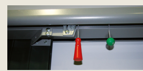
Débrayage manuel du moteur à l'intérieur du garage en cas de panne de courant
