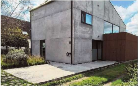
De gevel werd opgetrokken met geïsoleerde betonpanelen.
