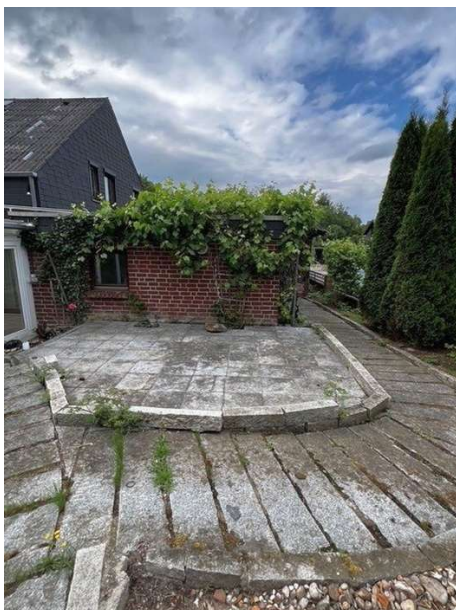
Zugang zum Carport
