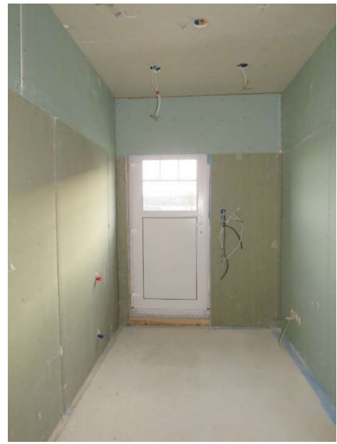
Anschlußraum im EG
