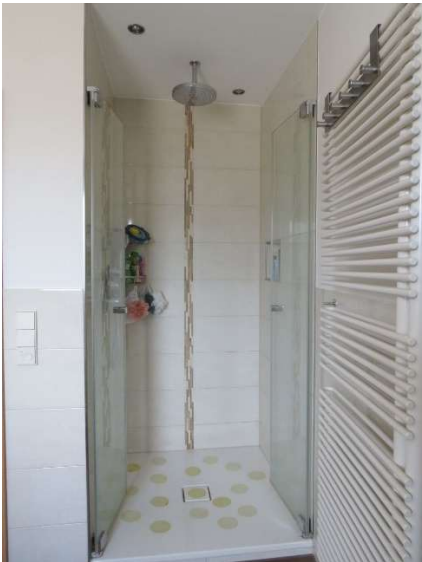
Dusche im Bad im OG
