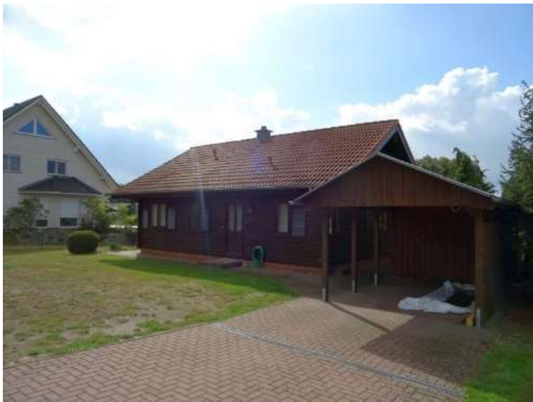
Objektansicht mit Carport
