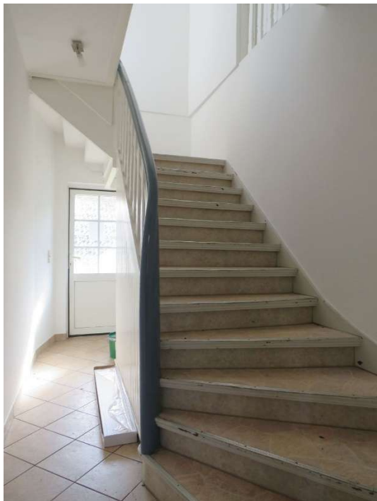
Treppe zum DG
