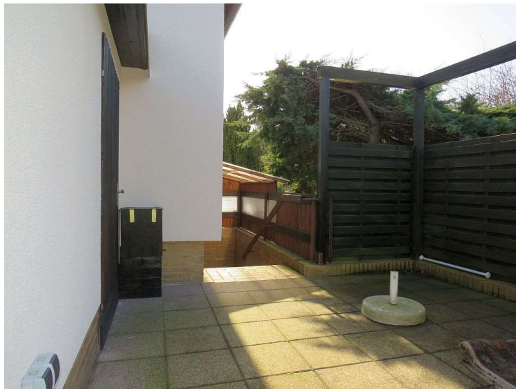
Terrasse mit Zugang zum Keller
