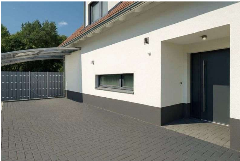
Zugang Wohnung im EG
