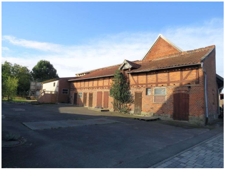
Innenhof mit Nebengebäuden
