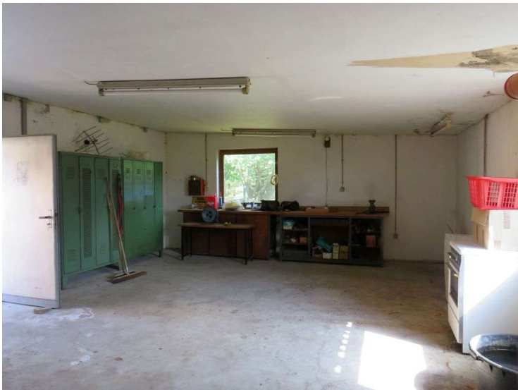
Nebengebäude mit Werkstatt
