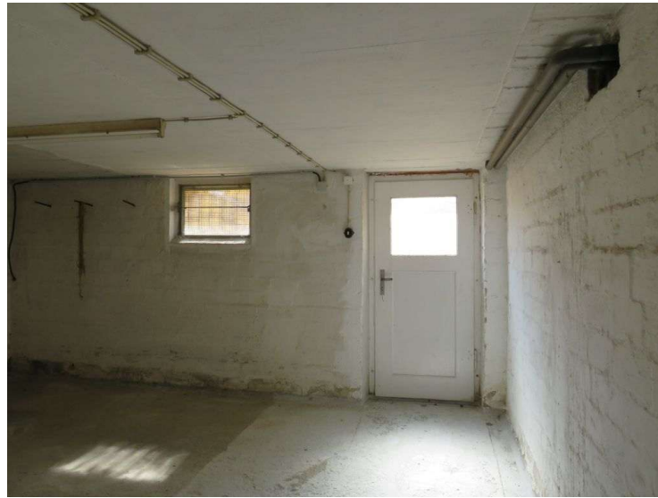
Keller mit Zugang zum Garten
