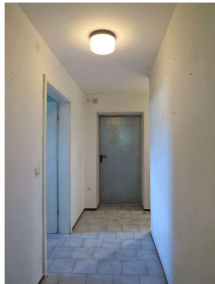
Flur im Keller
